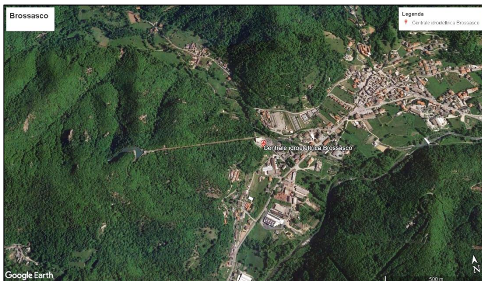
Figura 2.35 Ortofoto satellitare dell'invaso Brossasco. Risulta essere evidente il canale di derivazione che congiunge l'invaso con la centrale idroelettrica posta a ovest del comune di Brossasco. (Elaborazione software Google Earth, 2021)
